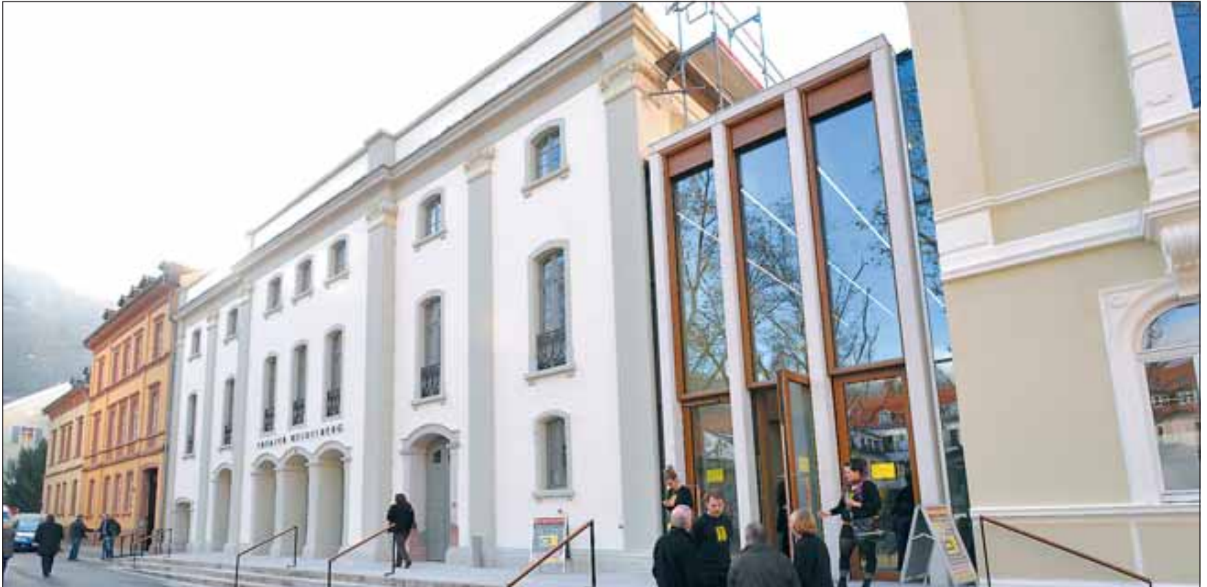
Die Fassaden der Theaterstraße 4 bis 10. Das ehemalige gläserne Foyer wurde abgerissen und alle alten Gebäude wurden durch die Betonstelen-Glas-Konstruktion wie mit einem Passepartout umrahmt. Vom eigentlichen Neubau sieht man deutlich mehr aus der Perspektive der Friedrichstraße (Seite 6). Foto: Kresin
