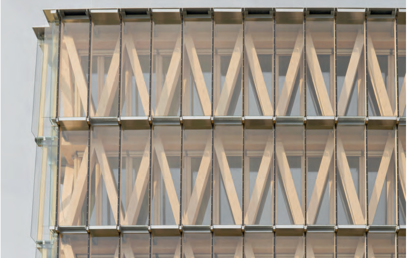
De 3,5 m hoge slagvaste beglazing, geplaatst in een geschubd patroon, is zo transparant mogelijk. Roosters in de gevel zorgen voor natuurlijke luchtstromen.
