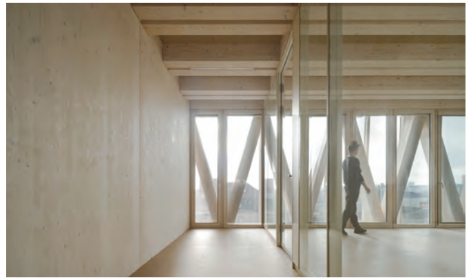
De verdiepingshoge 'binnenschil' kan op veel plekken handmatig worden geopend. De makkelijk verplaatsbare ruimtescheidingen lijken op de binnengevel.
