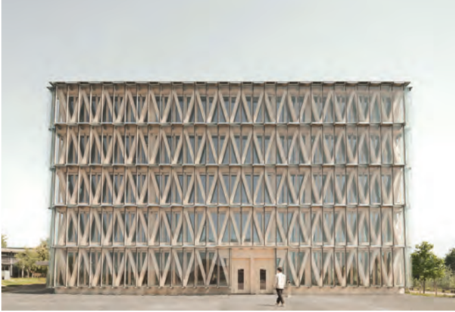
De tweedehuidgevel dient voornamelijk als bescherming van de houten gebouwschil en het textiele zonnescerm.
