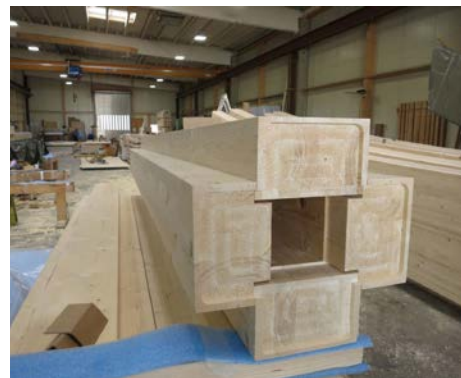
Die kreuzförmigen Stützen der Holzkonstruktion sind teilweise so ausgeführt, dass die Entwässerung im Inneren verlaufen kann Fotos (4): Grossmann Bau
