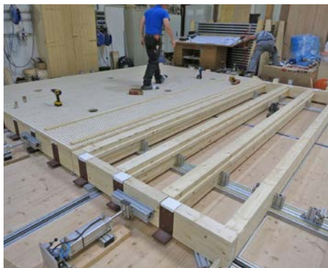
Hohlkastenelemente aus KVH, vorgefertigt und gedämmt bei Grossmann Bau in Rosenheim, wurden in die Tragkonstruktion aus Brettschichtholz eingefügt
