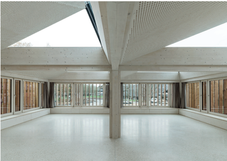
Akademie der GIZ am Campus Kottenforst, Bonn: Die Holzstützen in Kreuzform sind gestaltprägend und ermöglichen einfache Anschlüsse mobiler und flexibler Trennwandsysteme Abb.: Thilo Ross Fotografie, Heidelberg
