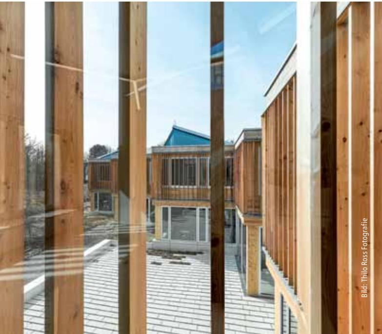
*Außenliegende, vertikale Lärchenholzlamellen verschatten das Obergeschoss; sie werden dabei von innenliegenden Beschattungssystemen unterstützt.*
