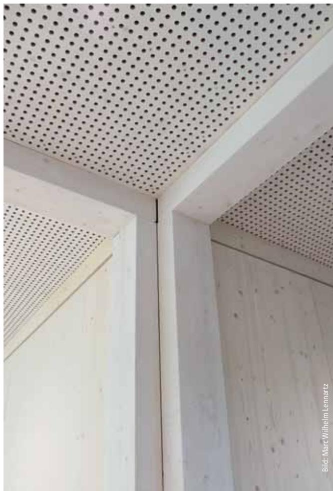
Unterseitig sind die Dreischichtplatten der Deckenelemente in weiß lasierter Sichtqualität mit definierten Lochungen für die Akustik ausgeführt.
