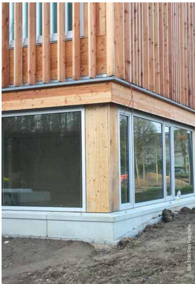
Der Holzbau wurde auf einem mineralischen Sockel inklusive einer Brüstung aus Betonfertigteilen platziert.
