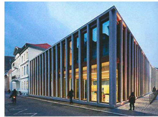
Hinter der Fassadenstruktur aus hell eingefärbten Sichtbeton-Fertigteilen und Glaselementen werden die Werkstätten und Probenräume wie in einem Schaufenster sichtbar. | Behind the façade structure of light-coloured, pre-cast exposed concrete and glass elements new workshops and rehearsal rooms are visible as if in a shop window.
