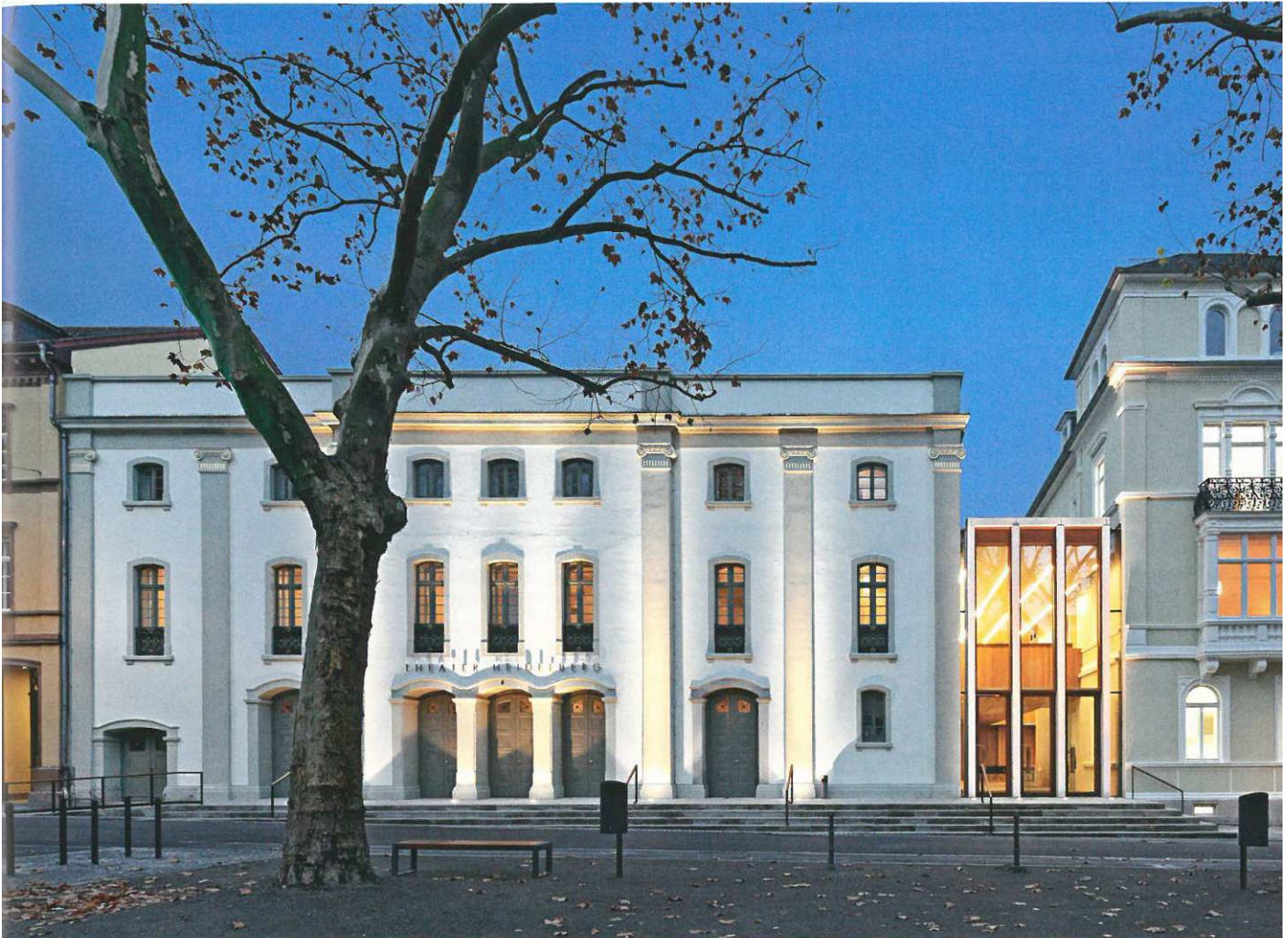
Der Besucher betritt das Theater über das neue Foyer in der gläsernen Fuge des Neubaus an der Theaterstraße. Visitors enter the theatre through the new foyer in the glass link of the new building on Theaterstrasse.
