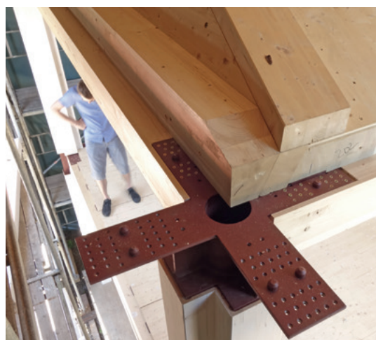
Die Kreuzstützen sind nicht nur gleichzeitig Installationsräume und Anschlüsse für flexible und mobile Trennwände, sondern auch gestaltprägende Elemente.
