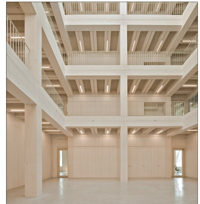
Die Tragstruktur der Innovationsfabrik bildet ein Holzskelett mit Balkendecken und ist um eine zentrale Halle organisiert. So erhält das Gebäude die gewünschte Offenheit.
