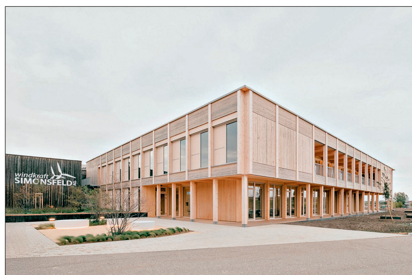
Das Tragwerk des zweigeschossigen Erweiterungsbaus der Windkraft Simonsfeld in Ernstbrunn (Österreich) basiert auf einem klar gegliederten Holzskelettbau, der Flexibilität für zukünftige Anpassungen sicherstellt. Foto: Patrick Johannsen
