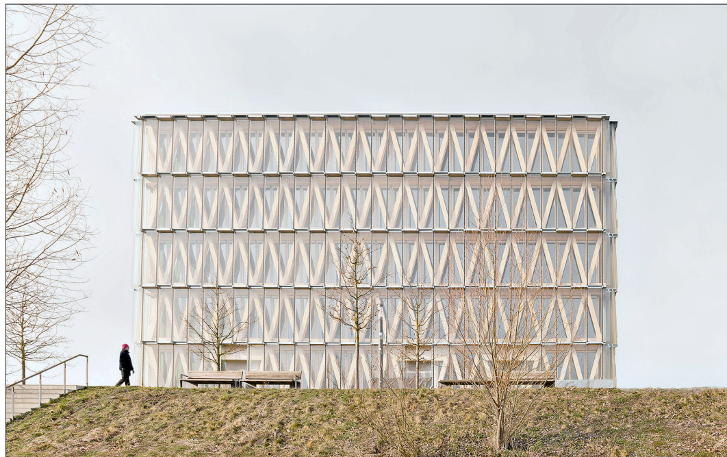
Der als Innovationsfabrik 2.0 bezeichnete fünfgeschossige Bürobau im Technologiepark Heilbronn: Die geschosshohen, V-förmigen Stützen, die durch die Glasfassade sichtbar sind, erzeugen das markante Erscheinungsbild des Gebäudes. Fotos: Brigida González
