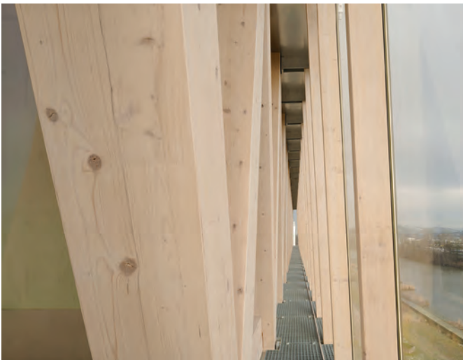
De 3,5 m hoge V-kolommen (300x280 mm) zijn vastgeschroefd in uitsparingen van de randbalken van de vloerplaat.
