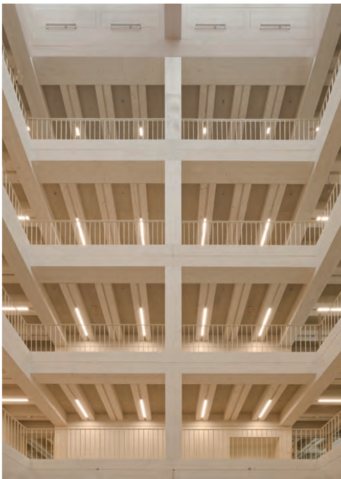
Tussen de forse dubbele draagbalken zijn de houtvezelplaten in het plafond niet afgetimmerd.
