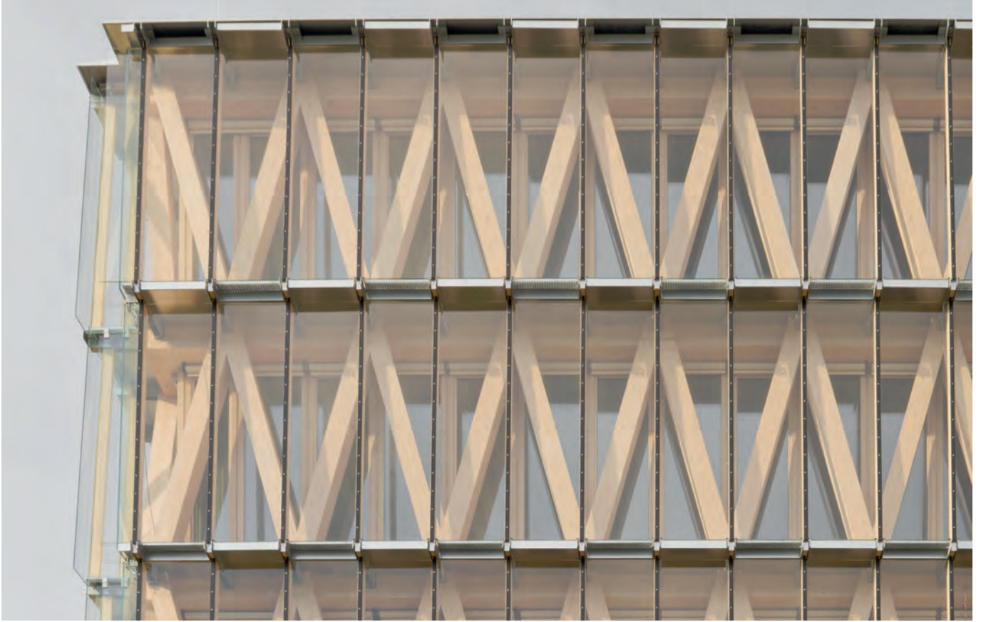
De 3,5 m hoge slagvaste beglazing, geplaatst in een geschubd patroon, is zo transparant mogelijk. Roosters in de gevel zorgen voor natuurlijke luchtstromen.
